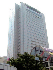
兵庫県立大学大学院応用情報科学研究科 がある神戸ハーバーランドセンタービル
