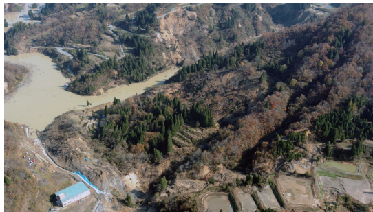
現場で確認された地すべり
