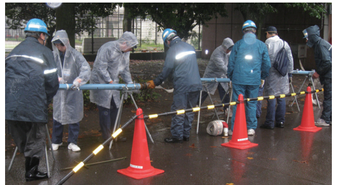
応急給水栓組み立て
