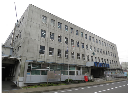
室蘭市庁舎外観
